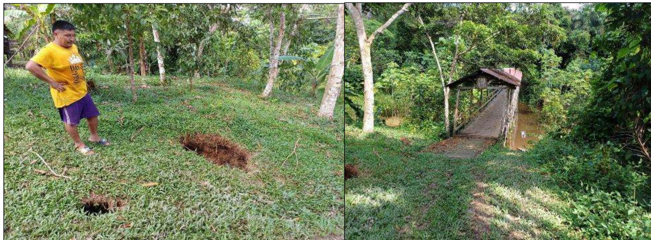
Fotografía N° 2. Señales de hundimiento o erosión cercanos a puente peatonal de madera de la localidad en estudio.
